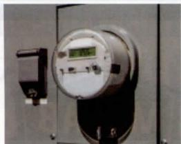
公用電力事業已經超過 100 年，但智慧電表的佈建與使用則處於起步階段。對這項公用事業來說，由於電表身為「前端的收銀機」，因此它必須準確。電表上配置許多的要求、規格及規則，而公用事業則設法確保電表存在準確度，但實際上，一個電表設計後一經認證、製造並佈建，大部份電表的準確度僅在它被製造測試當下才能知道。一個規制的電表如何在此領域運作直到它除役，可能只能透過統計抽樣測試得知。
